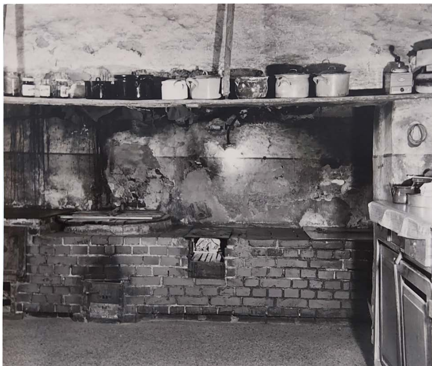
Die Küche mit dem gemauerten Herd. Von links nach rechts: Backofen, Waschkessel, Herd und Grude. Darüber der offene Schornstein. Vorn an der Schornsteinwand das Topfbrett.
