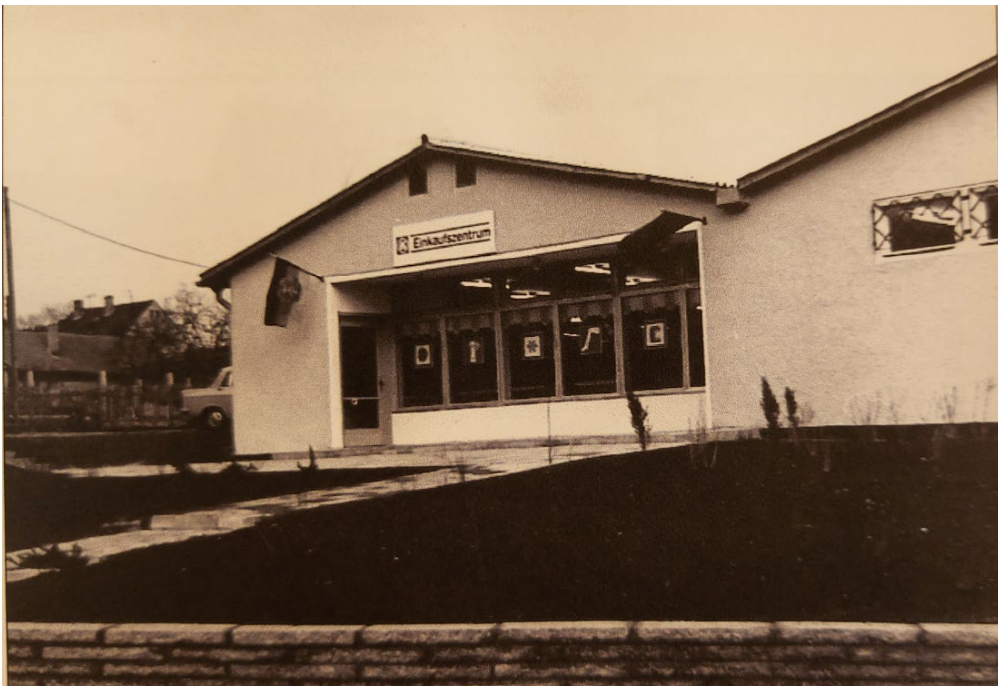
Die fertige Kaufhalle
