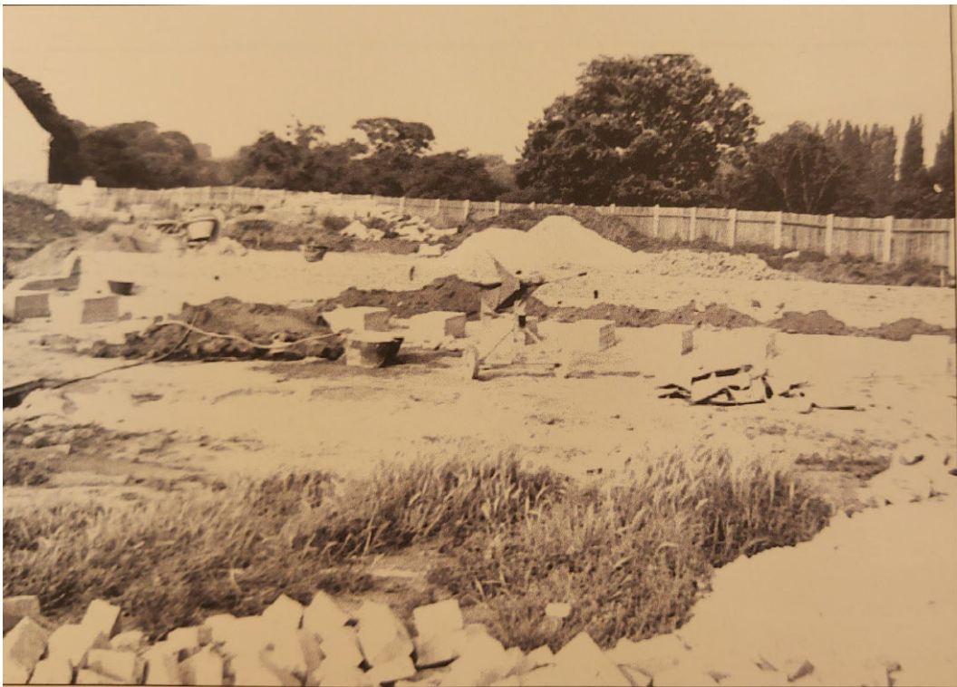
Die Baustelle für die Kaufhalle.
