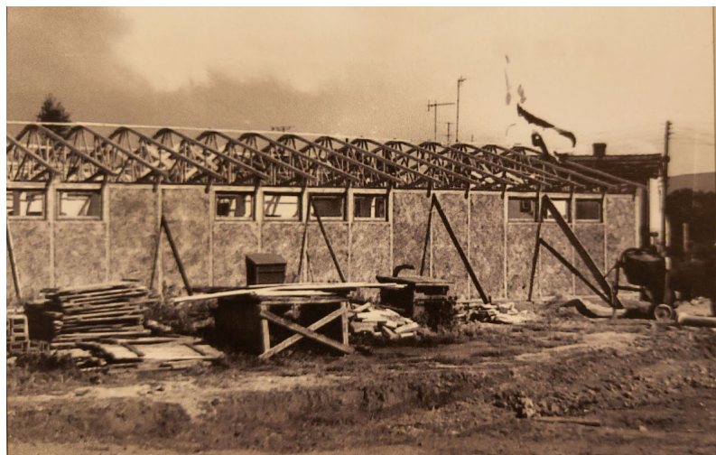
Aufstellung der Fertigteile.
