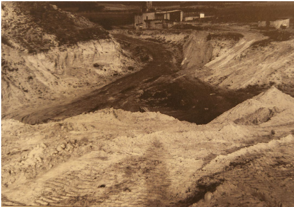
Die Einfahrt zur Sandgrube Rechts davon die Verloaderichtung für Güterzugwagen
