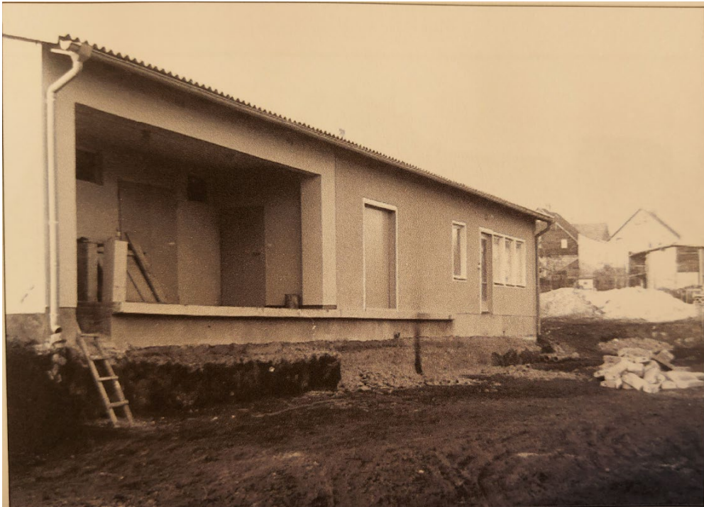
Die Laderampe kurz vor der Vollendung
