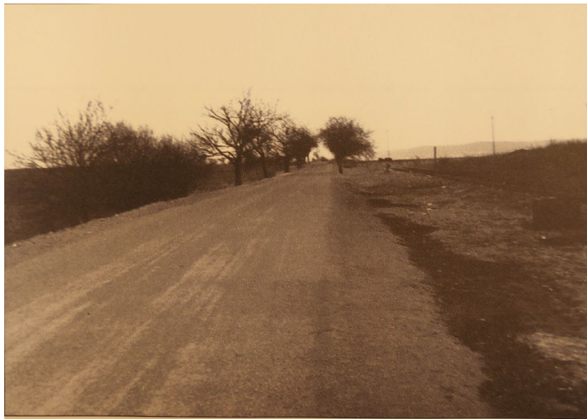
Die Straße ist fast fertig
