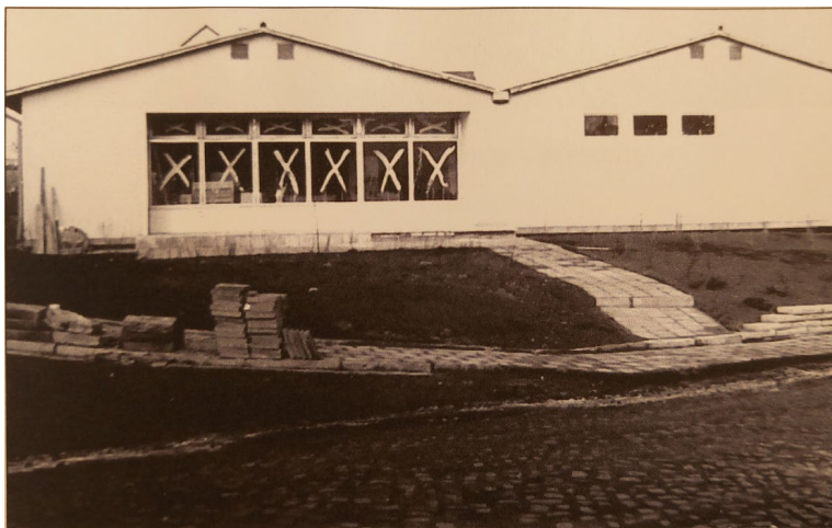
Der Rohbau ist fertig.
