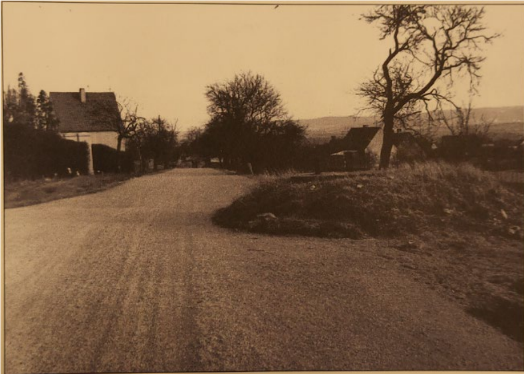
Am Ortsausgang von Weddersleben Die Erhöhung ist ein Kontrollschacht für die nach Warnstedt führende Wasserleitung.
