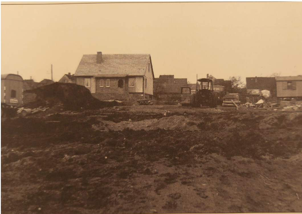
Während das erste Haus schon steht, werden die Ausschachtungsarbeiten fortgesetzt.
