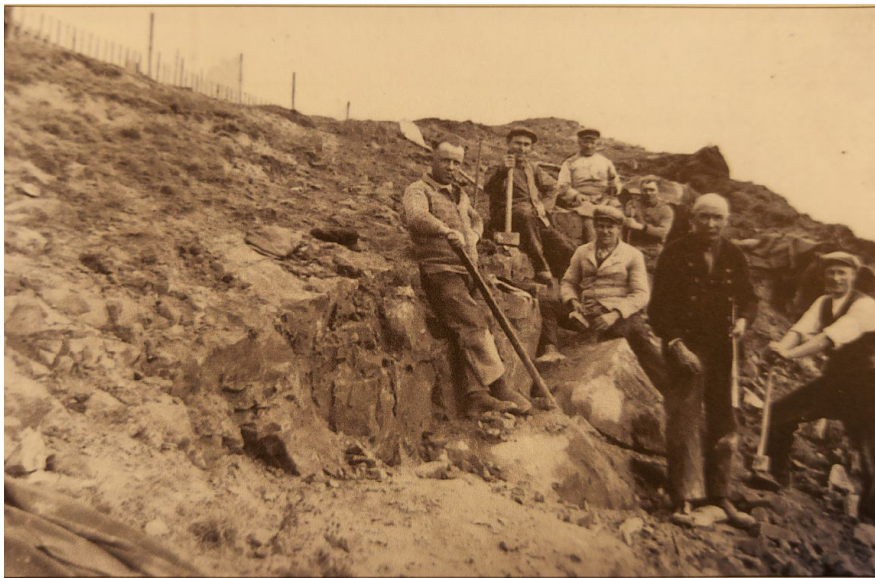
Arbeiten zur Gewinnung von Pflastersteinen im Steinbruch an den Königssteinen 1934. Sie sollten zur Umpflasterung der Breiten Straße (jetzt Friedensstraße) gebraucht werden.
