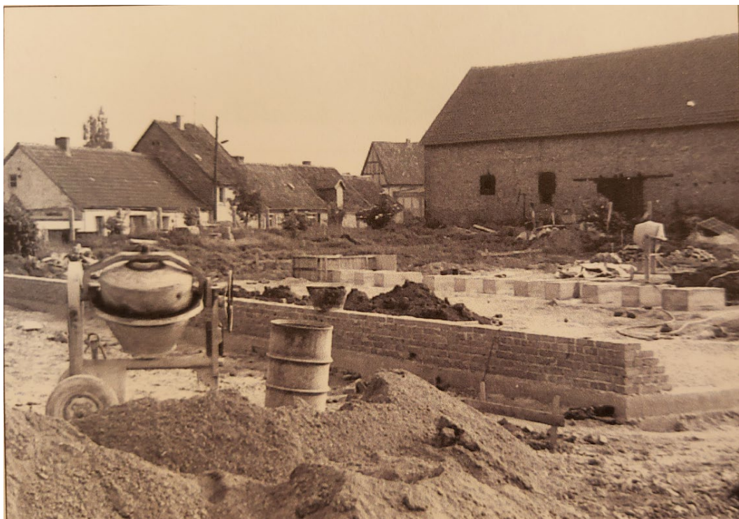
Die Grundmauern werden gebaut.
