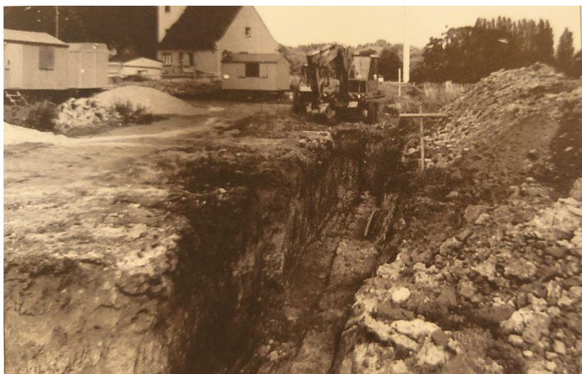
Die Muttererde wird abgetragen und zu einem großen Haufen zusammengesoben.
