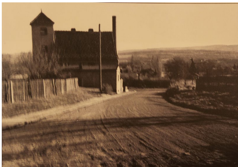
Die Reparatur des unteren Teils der Thiestraße im Herbst 1971
