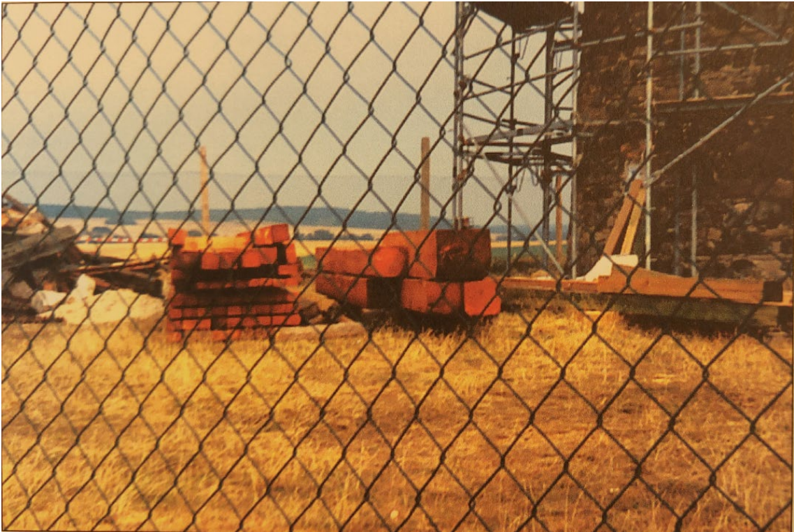
Starke Balken lagen auf der Baustelle
