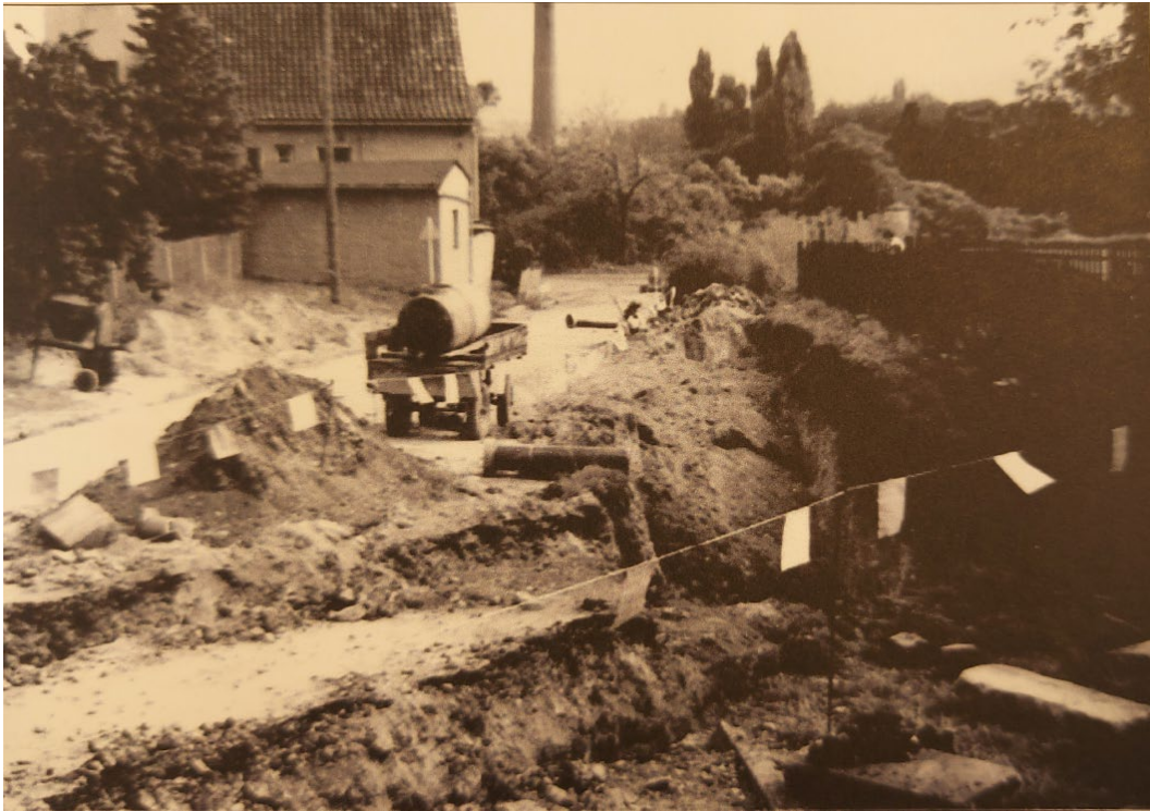
Hier wurde der Abwasserkanal von der Thiestraße aus der Klärgrube verlegt.
