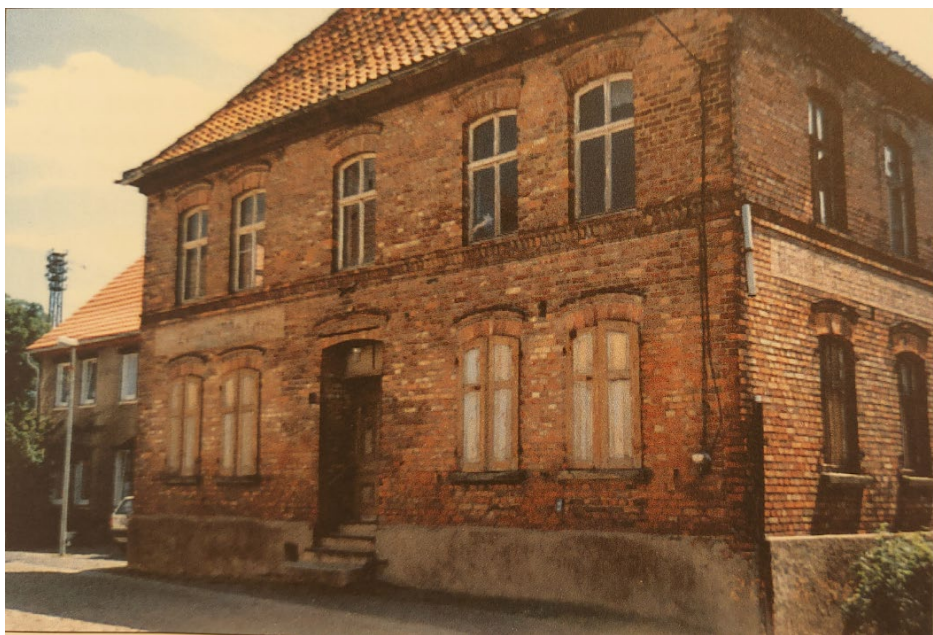
Eine Aufnahme aus dem Jahre 1998, als der Bau schon längere Zeit leer stand.
