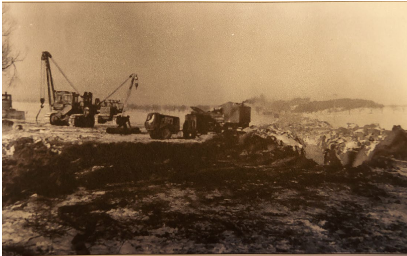
Bauarbeiten auf der Liete.
