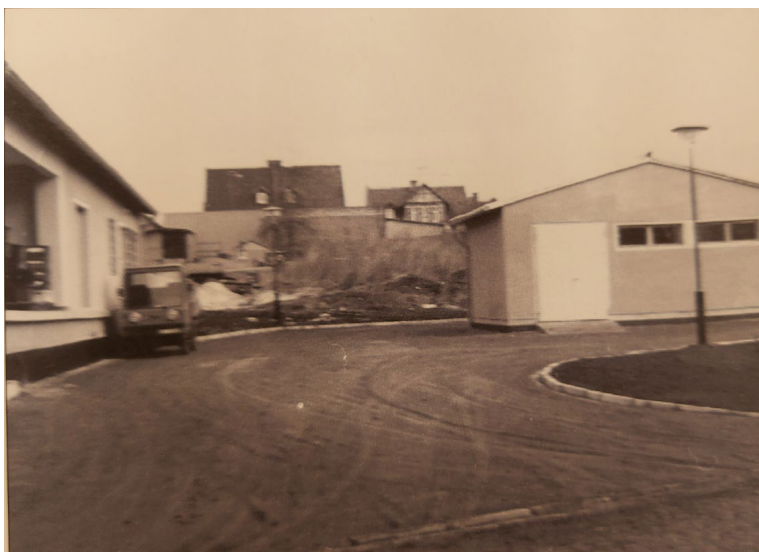
Die Rückseite der Kaufhalle mit der Laderampe. Rechts ein Leergutschuppen.
