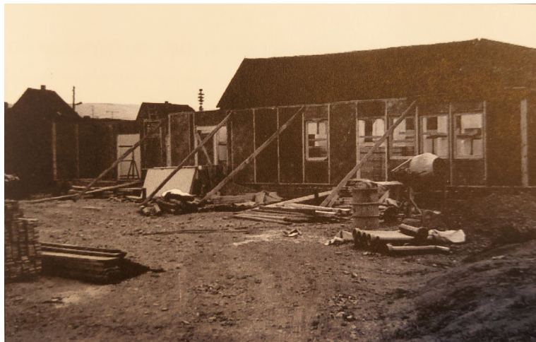
Der Bau geht weiter voran.
