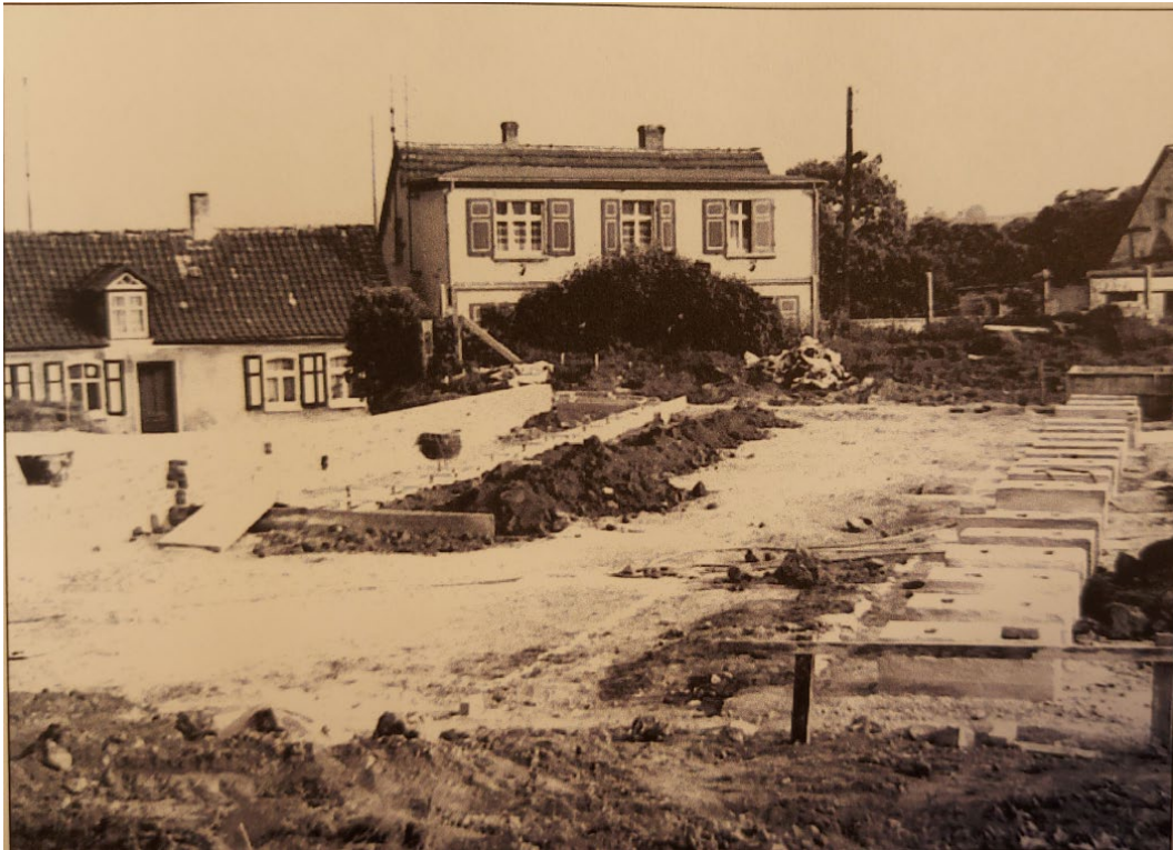
Sockel werden gebaut.
