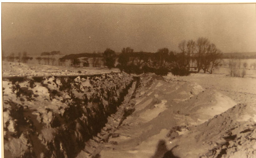
Leitungsgraben in Richtung Jordanbrücke.
