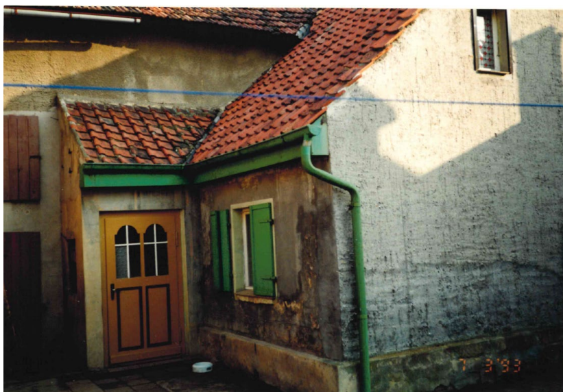
Nochmals das Haus in der Teufelsmauerstraße Nr. 20, Foto: H.J. Lerche 7.3.1993
