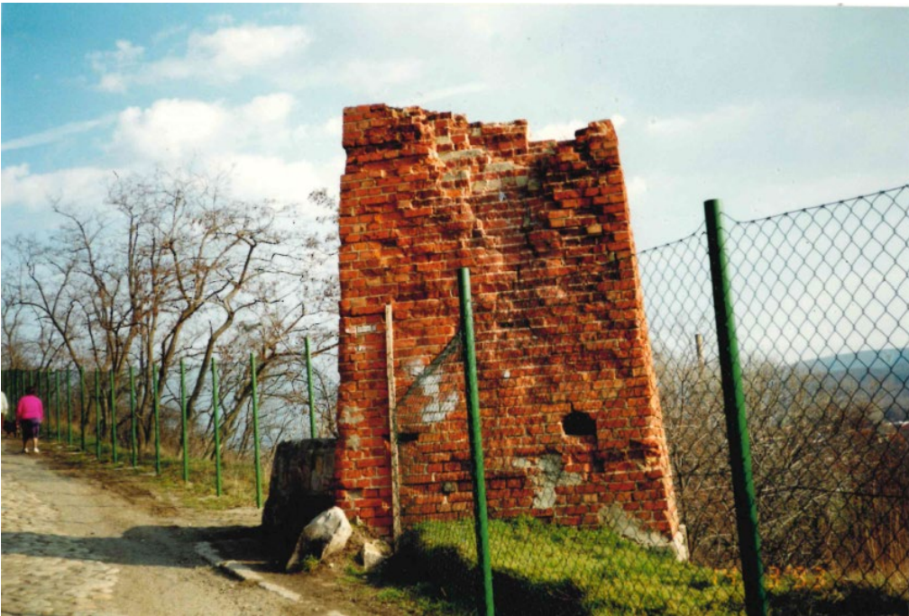
Der Weg nach Thale, über den Mühlenberg. Hier sieht man noch einen Pfeiler, der zur Ziegelei gehörte.
