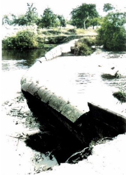
Blick auf das 1935 erbaute und 1946 durch Hochwasser zerstörte Bodewehr. (Kopie eines Fotos von 1952)
