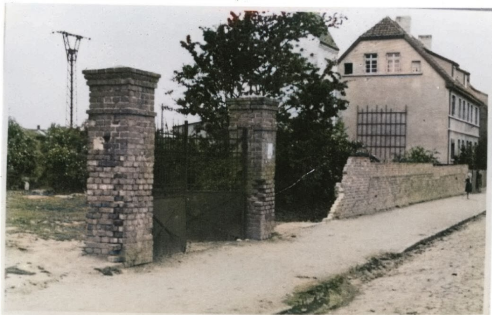
Friedhofsmauer im alten Zustand
