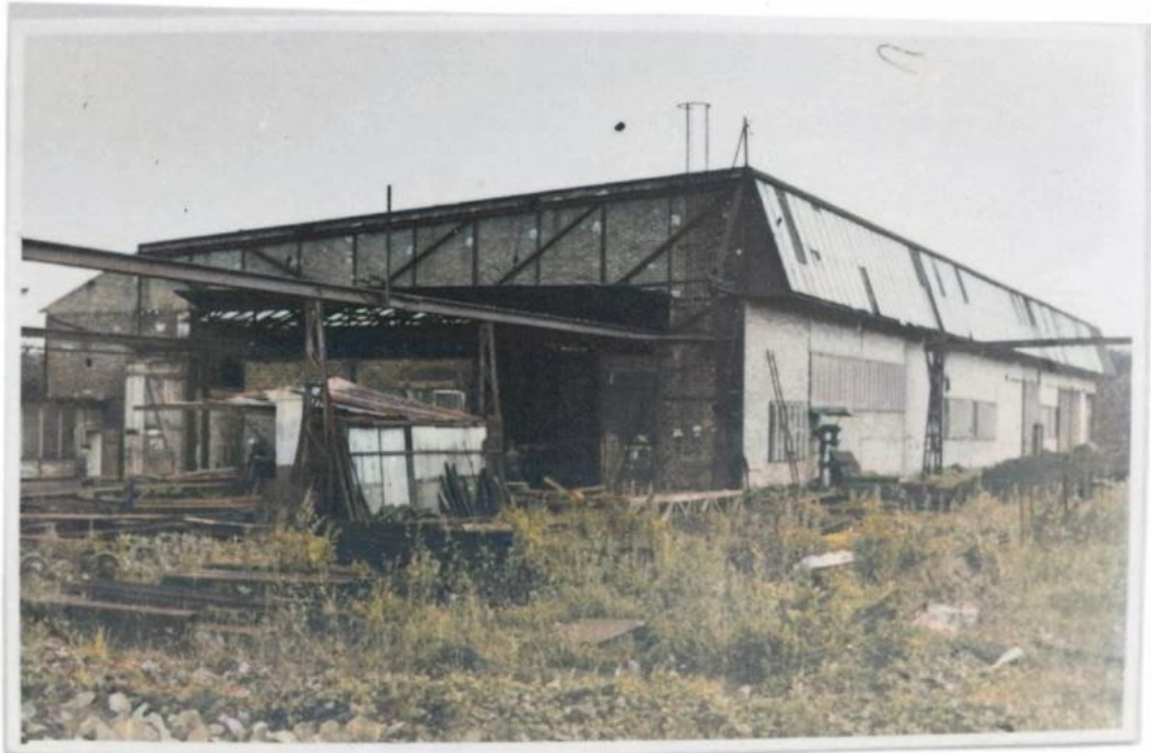
Die Volkseigene (VEB) Betrieb Stahlbau. (Foto von 1952)
