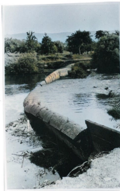
Das zerstörte alte Bodewehr. (Foto von 1952)
