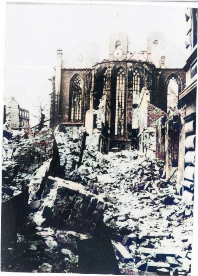
Die Jacobskirche von der Storchstraße aus gesehen.
