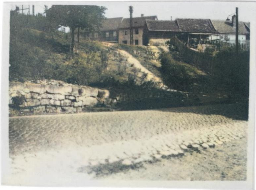
Vorderansicht mit der zerfallenen Mauer. (Foto von 1952)
