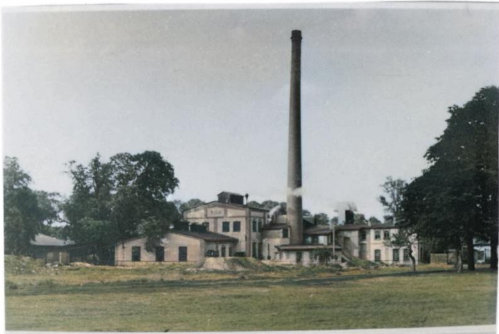
Die Papierfabrik, vom Anger aus gesehen. Davor Die Schutt- und Aschenhaufen (Foto von 1952)
