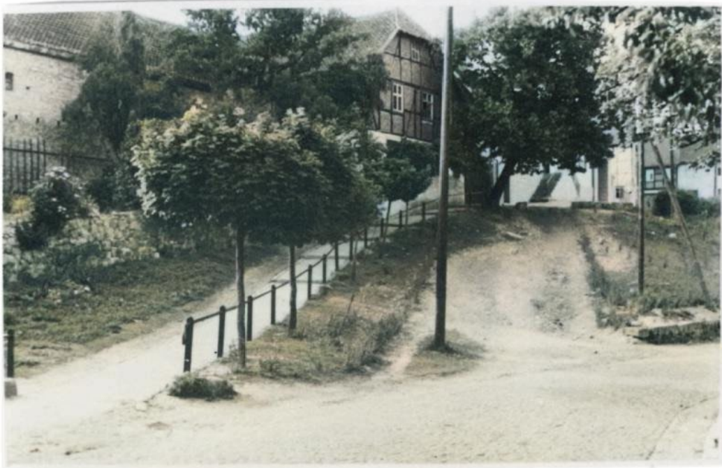
Bodeberg, Treppenaufgang. (Foto von 1952)
