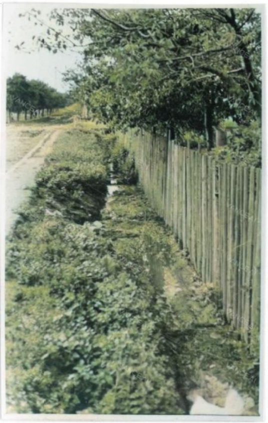
Abflussgraben für Schmutzwasser auf der rechten Seite der Bahnhofstraße (Foto von 1952)
