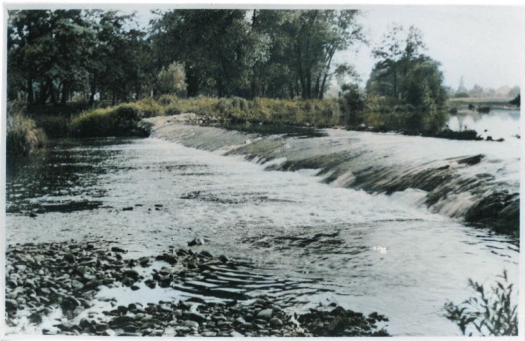
Das in Gemeinschaftsarbeit errichtete neue Bodewehr.
