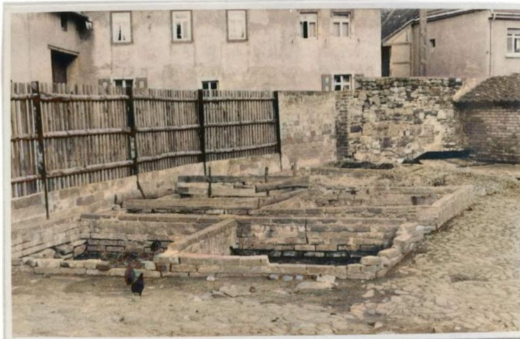
Grauer Hof, die Mistgrube, an der Bahnhofstraße gelegen. Zeitgemäß hatten die Wohnungsinhaber auch Ziegen und Schweine. Den anfallenden Mist benötigen sie zur Düngung der Felder und Gärten. (Foto von 1952)
