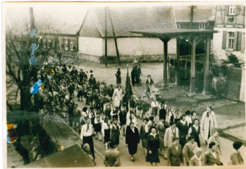
Der Festumzug in der Quedlinburger Straße, vorbei am Dach der alten Tankstelle vor der Schmiede.
