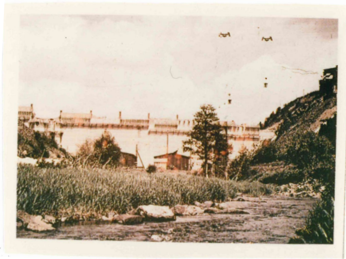
Wasserseitige Ansicht der Rappbodetalsperre während der Bauarbeiten mit Kabelkränen
