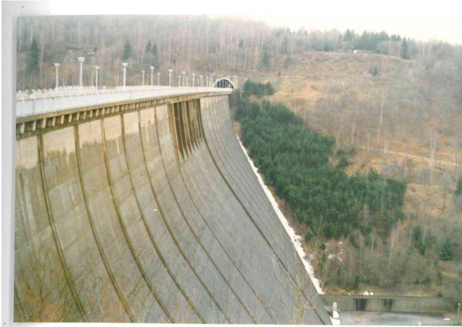
Ansicht der Rappbodetalsperre, April 1994
