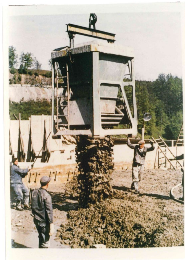
Baubetonkübel mit einem Fassungsvermögen von 2,0 \text{ m}^3
