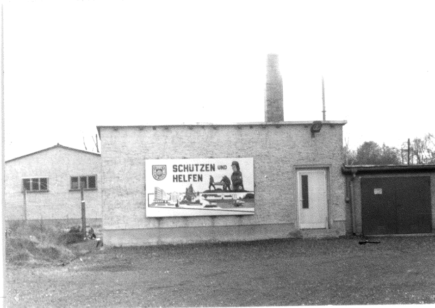
Moderne Stromversorgung und Heizung für das Objekt. (Foto Lerche 1983)
