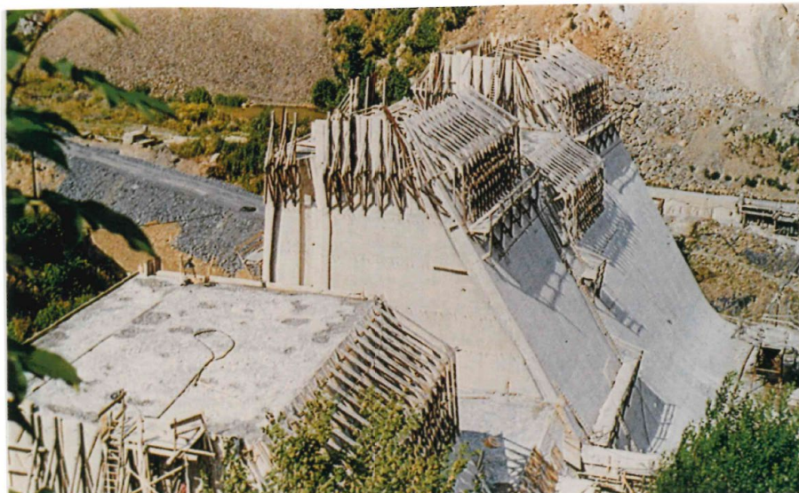
Luftseitige Ansicht der Talsperre Wendefurth während der Bauarbeiten.
