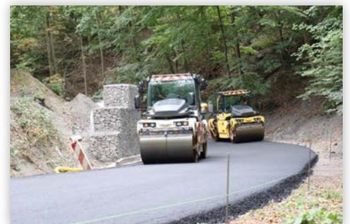
wichtige Vorarbeiten. So wurde im Auftrag des Landkreises Harz im unteren Bereich eine 300 Meter-Verrohrung samt zwölf Zuläufen eingebracht, um die Straße künftig bei Regen besser zu entwässern. Zur Stabilisierung einer Böschung entstand eine Gabionenstützwand. Sie ist 28 Meter lang und drei Meter hoch. Die Kosten beliefen sich auf knapp eine Million Euro.
